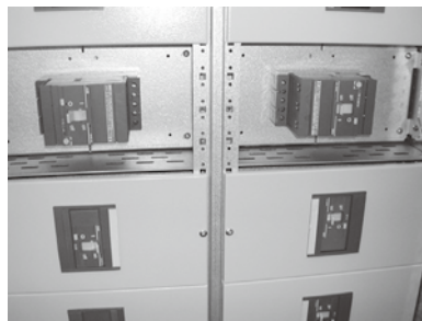
装置单元两列平排 (可节省回路出线空间)
