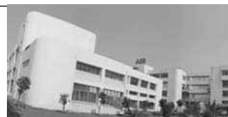
新会ABB厂房外景
