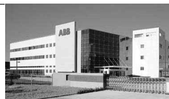
北京ABB厂房外景
